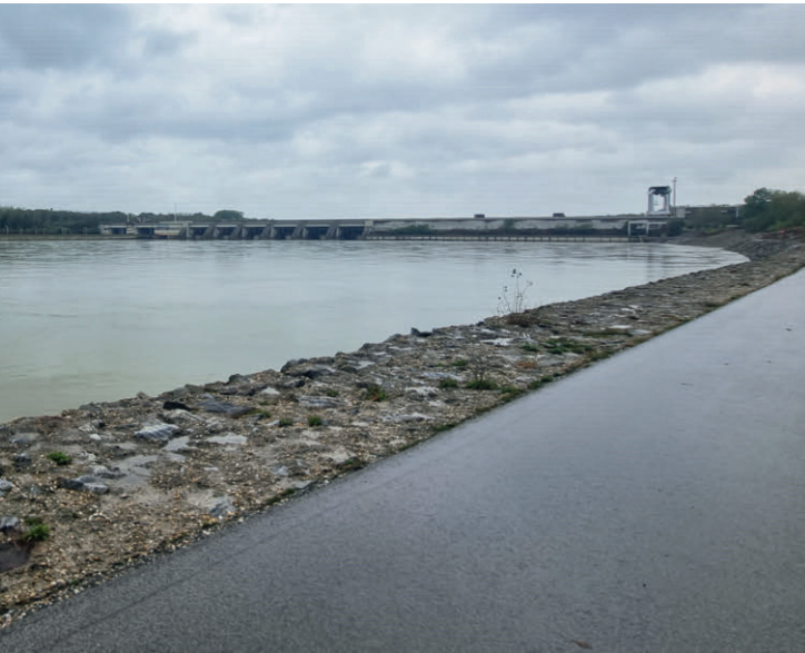
Abb. 2: Laufkraftwerk Greifenstein, Blick vom Donauufer Richtung Westen, 2024
